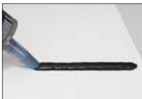
Afb. 1: Breng rups aan op originele ondergrond
